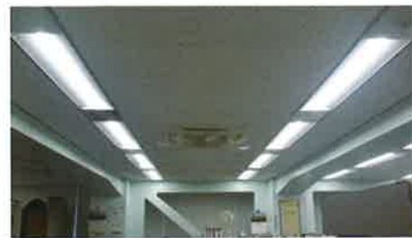
2階事務室照明・工事後
