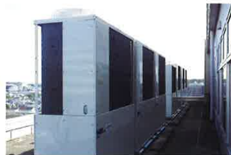
GHP 室外機・工事後
