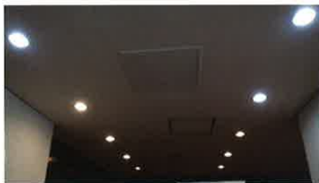
1階 EV ホール前照明・工事前
