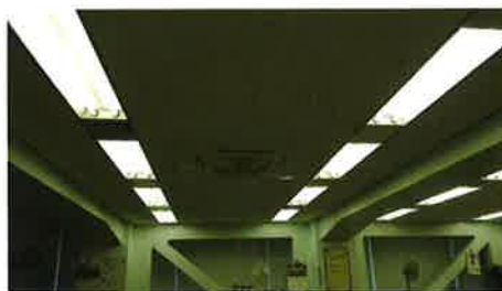
2階事務室照明・工事前
