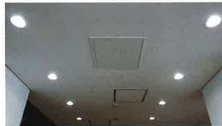
1階 EV ホール前照明・工事後
