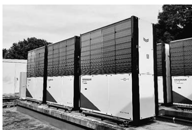
ガスヒートポンプエアコン
