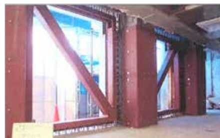
補強工事の様子(柱鋼板巻、タスキ型ブレース)
